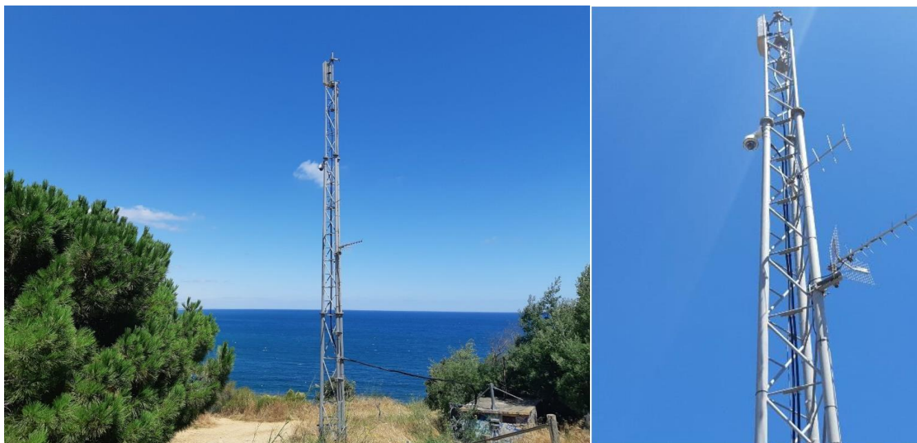
Illustration 38 - Système de suivi par caméra vidéo du Racou. En haut : localisation générale ; en bas à gauche : pylône TDF et local technique ; en bas à droite : caméra fixée sur le pylône.
