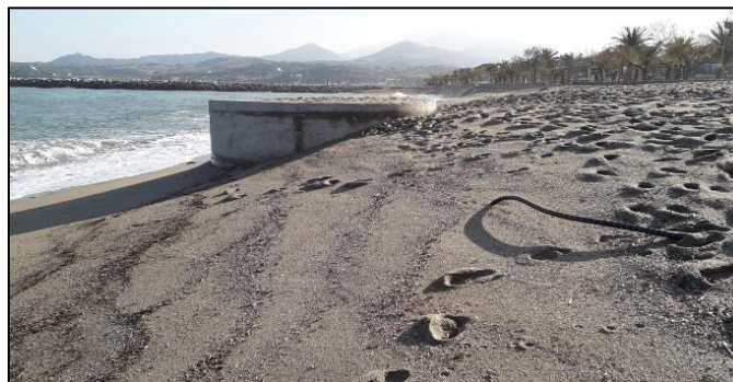
Illustration 88 – Recul du trait de côte et érosion au niveau du regard béton de l'émissaire de la station d'épuration d'Argelès-sur-Mer (source DDTM 66 30/11/2020)
