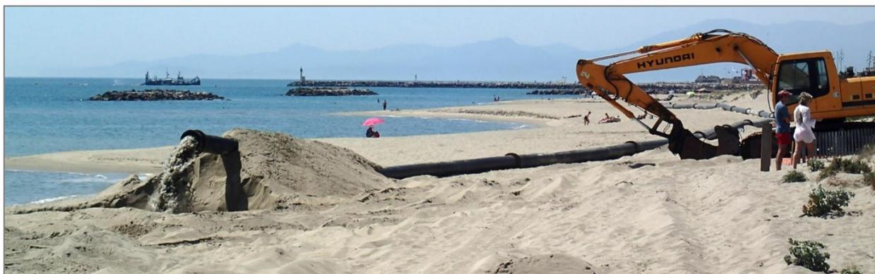
*Illustration 44 : Travaux de dragage et de rechargement par pompage hydraulique (Le Barcarès, juin 2014)*
