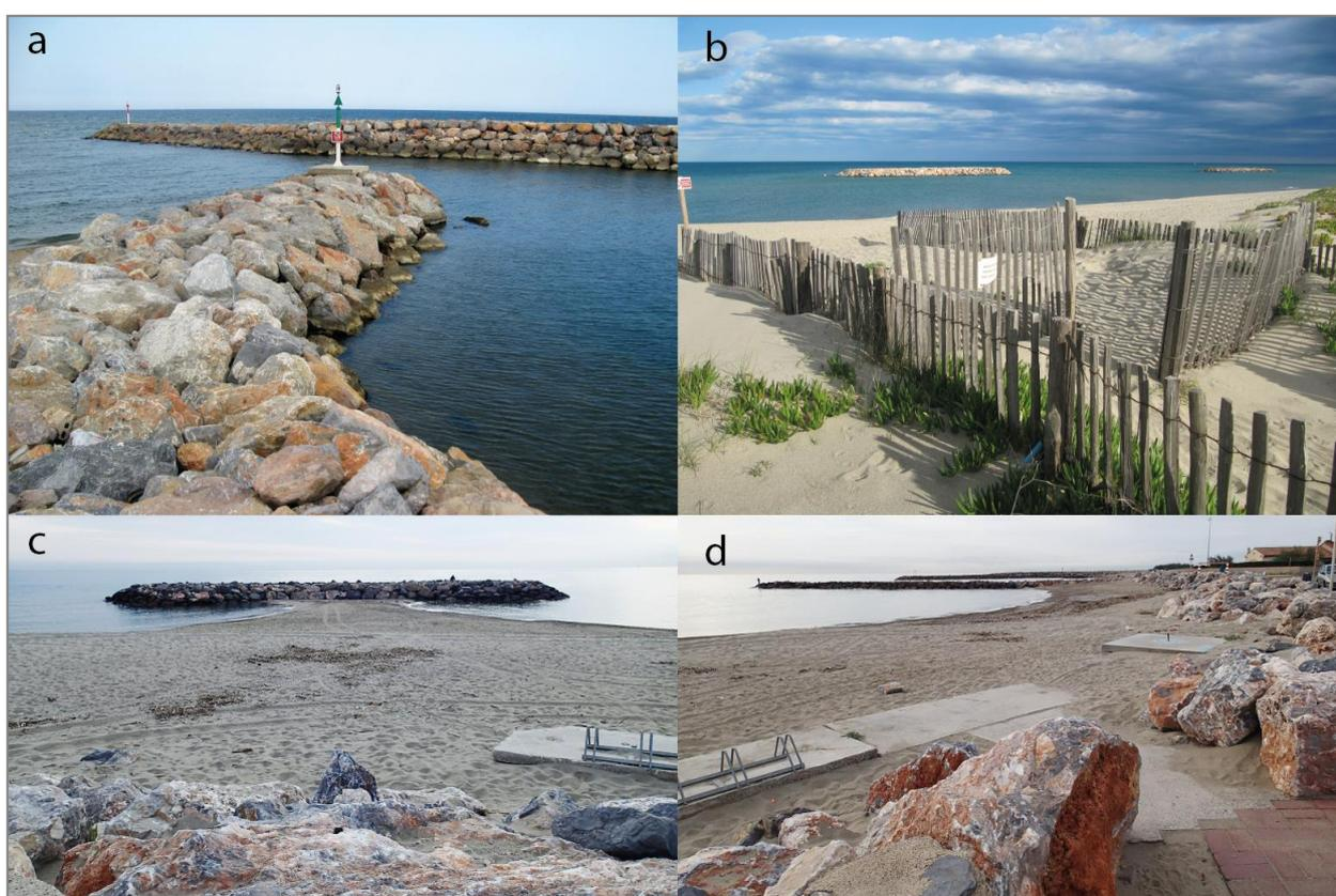
*Illustration 41 : Photographie d'ouvrages dans le Roussillon (a : jetée de port ; b : ganivelles et brise-lame ; c : brise-lame ; d : épis et enrochements de haut de plage)*
