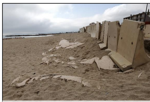
Etat des modules au boulodrome
