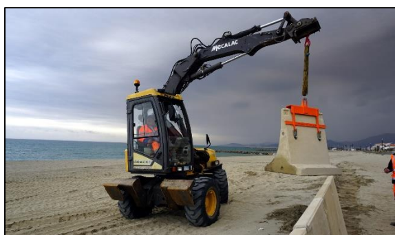
Installation des Waves Bumpers en centre-ville
