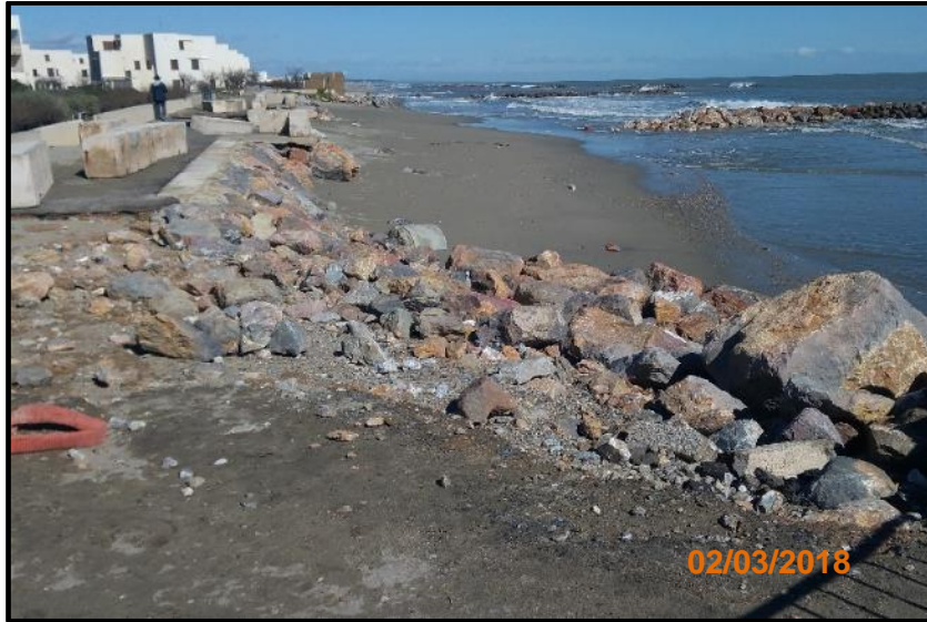
Illustration 94 - Dégâts engendrés sur la promenade de la mer (balladoir) au niveau de l'épi sud (EP1) par la tempêtes du 1 er mars 2018.
