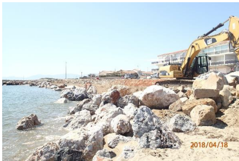
Illustration 170 - Travaux de mise en place de nouveaux enrochements entre le premier épis et le premier brise lame par la commune de Sainte-Marie en Avril 2018.
