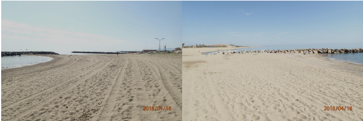
Illustration 165 - Secteur de Sainte-Marie au niveau du profil topographique de référence BT064040 (secteur des ouvrages). A droite, vue vers le Nord, accumulation de sable en aval-dérive du dernier épi ; à gauche vue vers le Sud, tombolo au droit du dernier brise-lames, plage en forme de baie. Campagne ObsCat 18 Avril 2018.
