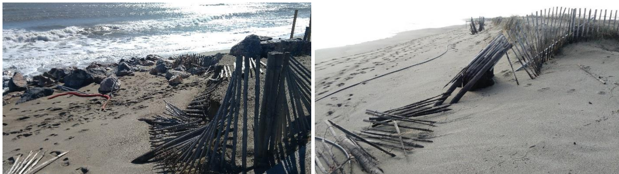
Illustration 131 - Photographies des dégâts au niveau du poste de secours de la plage nord (à gauche) et sur le système de ganivelles (à droite) après la tempête du 1 er Mars 2018. Source : photothèque ObsCat.
