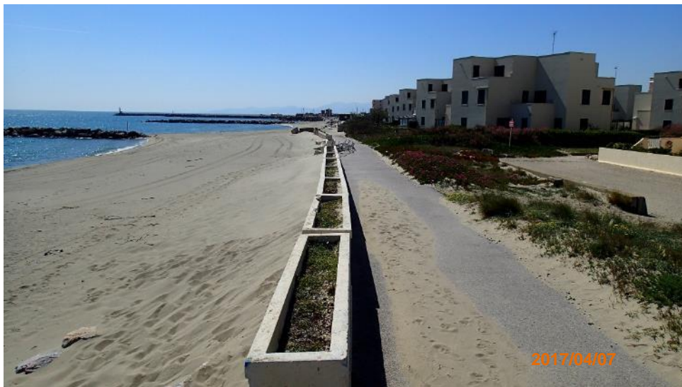
Illustration 88 - Morphologie de la plage, formation d'un tombolo, au droit du second épis au niveau des Miramars (prise de vue du 07/04/2017).
