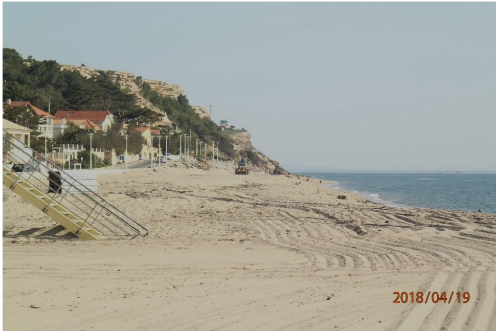
Illustration 46 - travaux de reprofilage de plage dans la moitié nord du secteur de Leucate.
