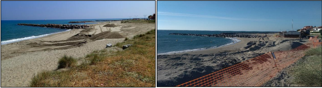
Illustration 167 - Opérations de rechargement le 24 avril 2017 et le 18 juin 2018 réalisées par PMM pour le confortement de l'ancrage de l'épi Nord de Sainte-Marie. Source ObsCat.
